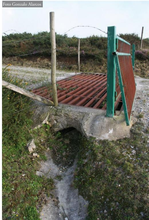
**Figura 1:** Ejemplo de modificación en paso canadiense con apertura de una de las paredes laterales para la salida de la fauna. Parque eólico en Cadavedo, Lugo.
