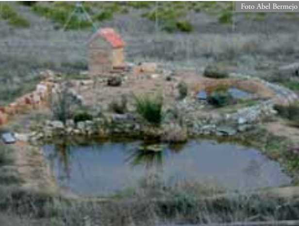
Figura 1. Primeras fases de la construcción del estanque en 2002.
